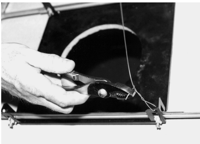
Afbeelding 9.4: Het beugelsysteem bevestigen
